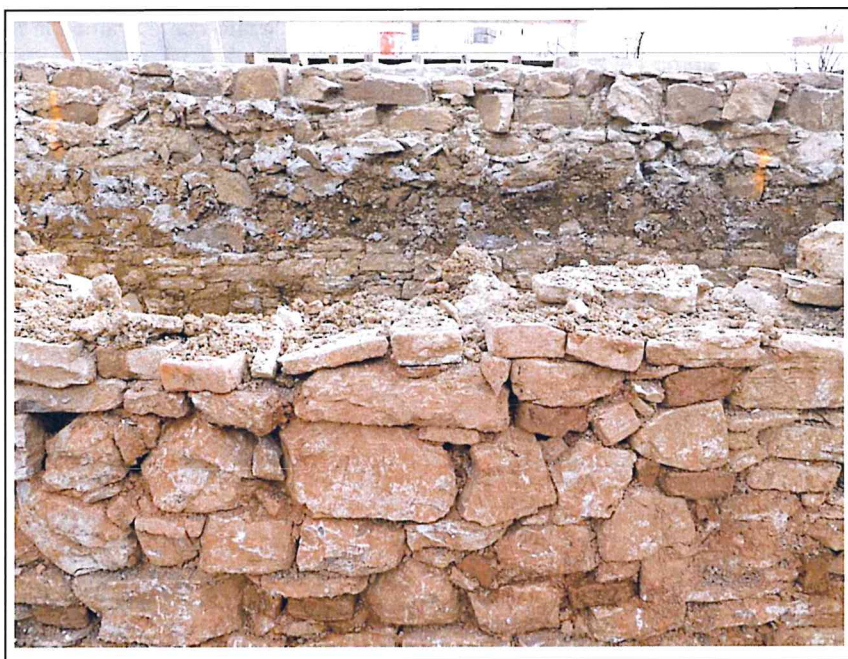
Bergamo - Monastero di Astino. Un'immagine in fase di scavo del muro realizzato a secco, sullo sfondo, in alto, la struttura muraria costruita sul muro di primo impianto della cortina muraria che cingeva il monastero.
