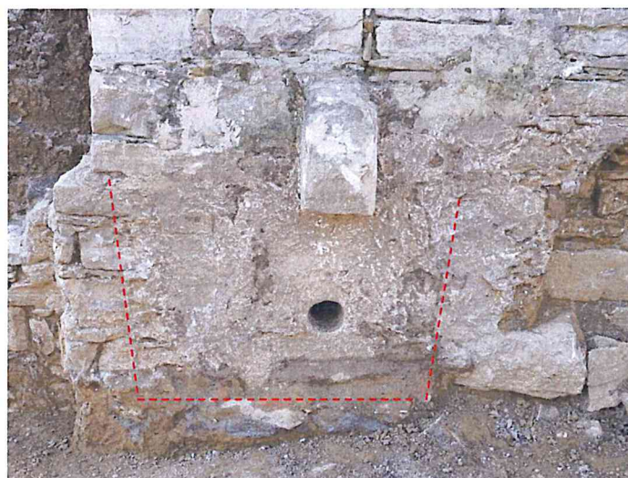
Bergamo - Monastero di Astino. Particolare del tratto di muro della vasca attraversato dal foro di scarico, visto da est. Si notano tracce evidenti di cocchiopesto e calcare che formano una sagoma rettangolare evidenziata dal tratteggio in rosso. (altra piccola vasca?)
