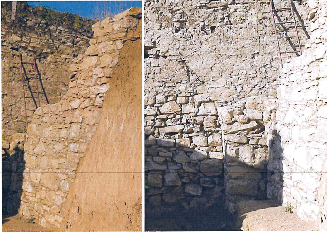
Bergamo - Monastero di Astino. Particolari delle strutture murarie e del tamponamento dell'antico passaggio rinvenuto nelle mura di cinta a sud.
