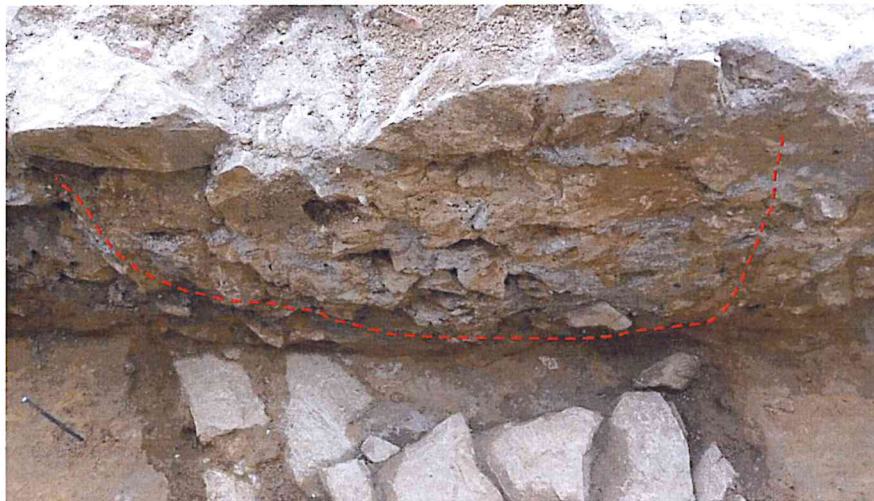
Bergamo - Monastero di Astino. Particolare del punto in cui la fondazione del muro nord della vasca/peschiera deborda.
