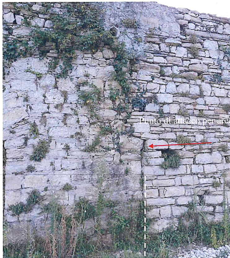
Bergamo - Monastero di Astino. Particolare del punto di attacco delle due murature costruite in tempi differenti. Il primo muro termina con una impostazione per proseguire con nuovo arco, mentre il secondo muro è realizzato senza utilizzare la predisposizione preventivata con la partenza di un successivo arco.
