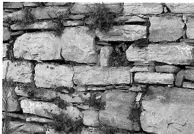
Bergamo - Monastero di Astino. Particolare della tessitura muraria della terza fase costruttiva del muro sud.
