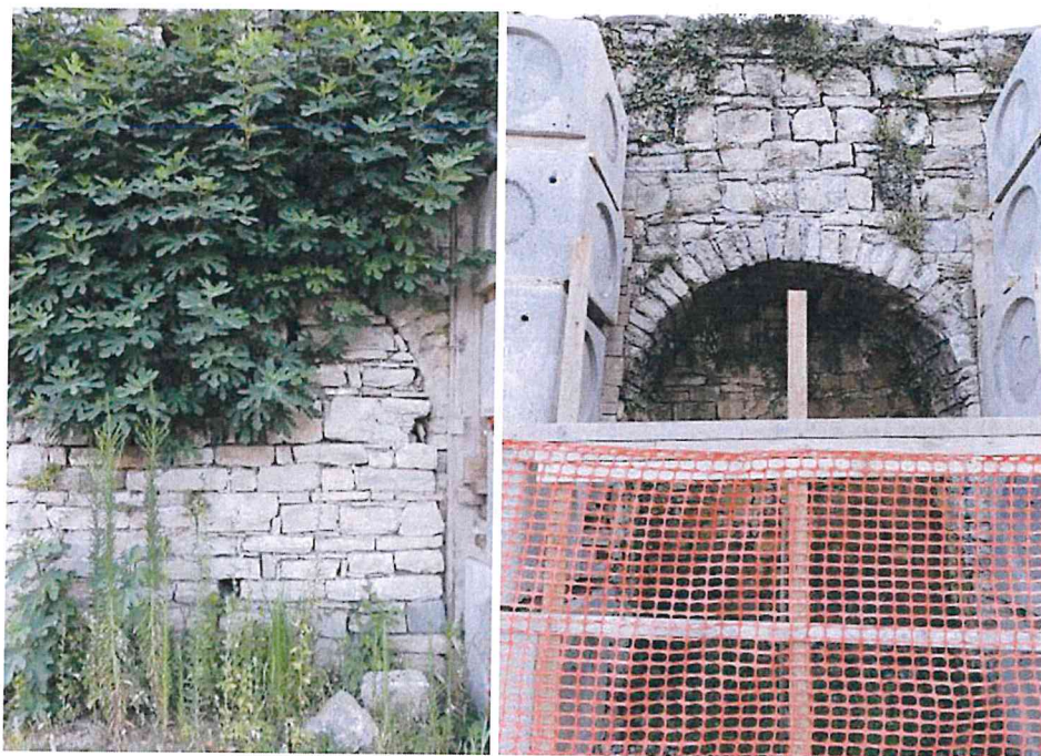
Bergamo - Monastero di Astino. Particolare del tratto murario dove sarà aperto il secondo ingresso. Nella prima foto si intravede sotto le fronde dell'albero del fico l'arco a ovest del futuro passaggio, mentre nella seconda foto si vede l'arco dove sarà praticato il taglio per il nuovo accesso.
