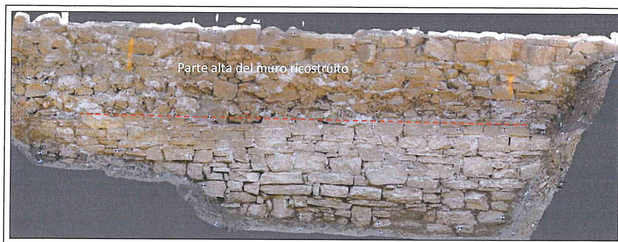
Bergamo - Monastero di Astino. Prospetto nord della struttura muraria, realizzata in fasi successive. In alto la parte di muro aggiunto e realizzato contro terra, in basso il muro più antico realizzato con entrambe le facce a vista. Le due tracce arancioni delimitano lo spazio del taglio da realizzare in breccia di m 4 di larghezza per realizzare l'ingresso ai nuovi bagni.
