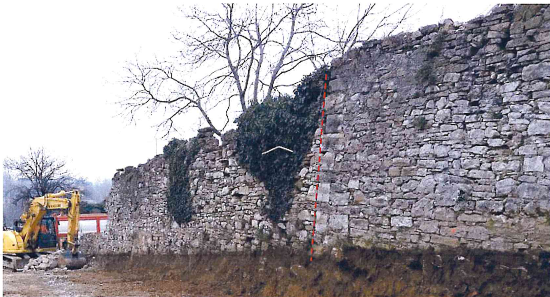
Bergamo - Monastero di Astino. Il muro est in fase di demolizione nella parte più a sud sino al punto in cui si appoggiava alla fase più antica data dai resti del muro della vasca. La linea rossa tratteggiata evidenzia il punto di contatto tra i due muri.
