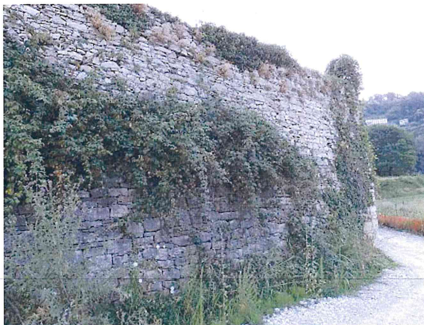
Bergamo - Monastero di Astino. Ultima fase di costruzione del muro di cinta a sud che si presenta con una cortina più arretrata verso nord e con una tessitura muraria in cui sono utilizzati conci di piccole dimensioni, mentre nel cantonale sud/est il muro ripresenta l'utilizzo di conci di dimensioni maggiori.
