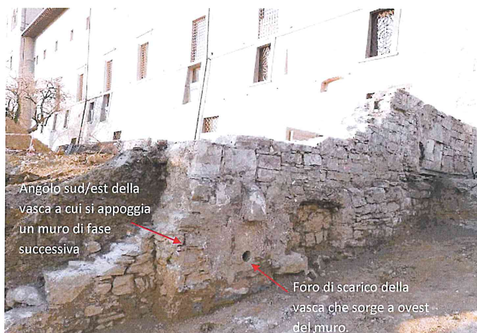
Bergamo - Monastero di Astino. Il muro est di cinta, particolare del tratto che ingloba il muro della vasca. Si nota il foro strutturato di uscita.
