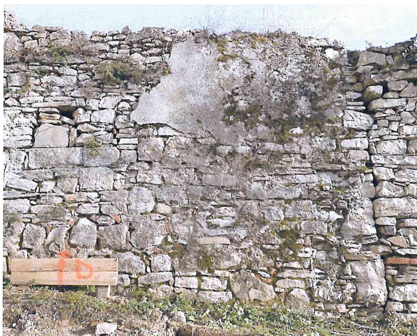
Bergamo - Monastero di Astino. Un particolare del punto in cui i due muri venivano a contatto visto da ovest dall'interno del perimetro del monastero. Su questo lato le rifiniture sono più grossolane, forse perché il prospetto della muratura doveva essere tutto intonacato, si nota in alto ancora una lente d'intonaco.
