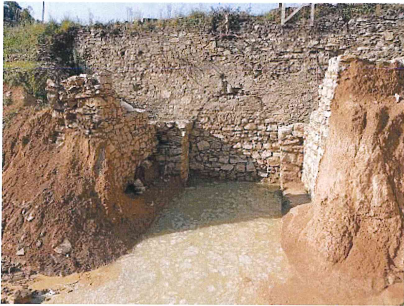
Bergamo - Monastero di Astino. Particolare dei due possenti muri realizzati con conci squadrati che delimitavano l'ingresso posto a sud del Monastero, passaggio successivamente chiuso da un tamponamento murario.
