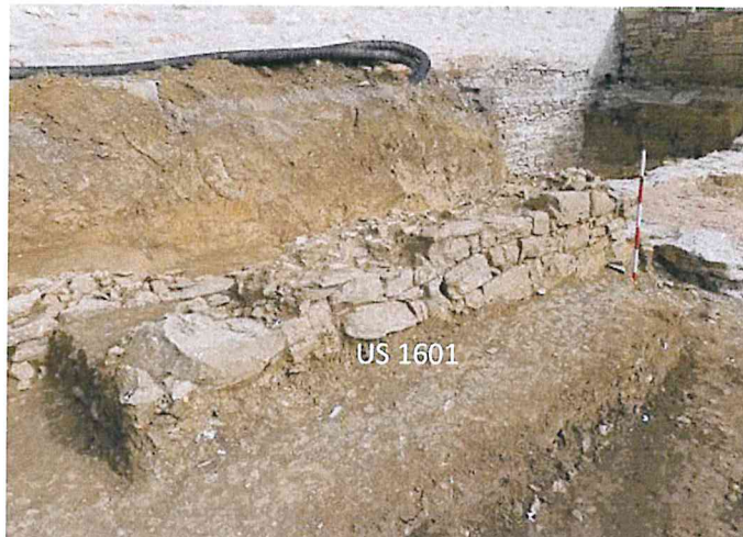
Bergamo - Monastero di Astino. Il muro US 1601 visto da ovest e da sud/ovest. Si nota la tecnica di costruzione contro terra con "pezzame" di dimensioni piccole e i conci sbazzati di maggiori dimensioni utilizzati per il prospetto sud.
