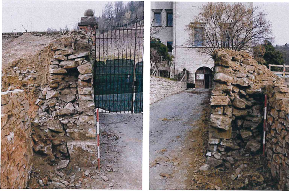
Bergamo - Monastero di Astino. La cortina muraria smontata del vialetto d'accesso alle cantine, si nota il paramento a vista realizzato con conci squadrati, mentre l'interno del muro è realizzato a sacco con pietrame misto. Alla base del muro sono state individuate diverse pietre di grandi dimensioni lavorate; queste presentano un lato con un ampio incavo scavato, sono uguali a quelle rinvenute nelle cantine alla base delle grandi botti.
