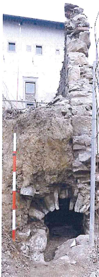
Bergamo - Monastero di Astino. Il secondo tratto della canalina è orientato nord/sud e i parte è sormontato dal nuovo muro, nel punto in cui li muro va a coincidere con il canale di scolo la copertura da piatta (formata da grandi lastre) viene costruita voltata. (vedi foto in fase di scavo)
